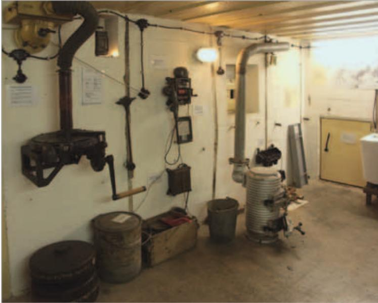
*Die wichtigsten technischen Einrichtungen, hier in einem restaurierten Unterstand: v.l.n.r.: Schutzlüfter, Abfalleimer (auf dem Boden), Laterne (in der Nische oben), Festungsfernsprecher, Eingangverteidigung (hinter Ofenrohr), Bunkerofen, Notausstieg (kleine Tür in der Ecke).*
