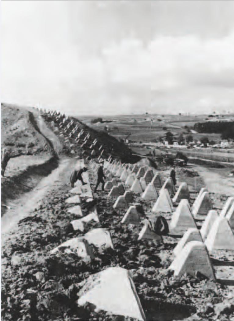
*Eine fertiggestellte Höckerlinie vom Typ A (alte Bauart 1938).*
