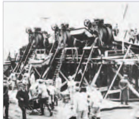
*Links. Batterie von Betonmischern zum Bau eines Westwallbunkers in der Feldmark Büchelberg.*
