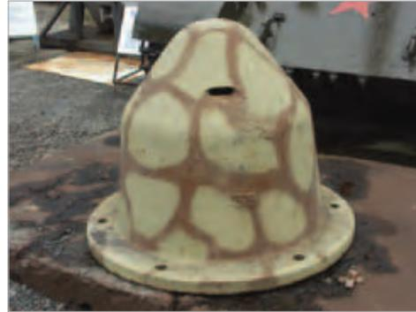
*Eine Kleinstglocke zur Beobachtung aus dem Bunker. Nur die Spitze ragte aus dem Beton heraus.*
