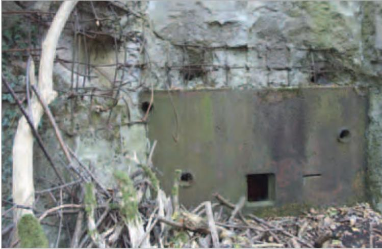
*Die Illusion von Sicherheit. MG-Bunker mit drei Durchschüssen von 76-mm-US-Panzerkanonen in der Scharthenplatte 1944/45.*
