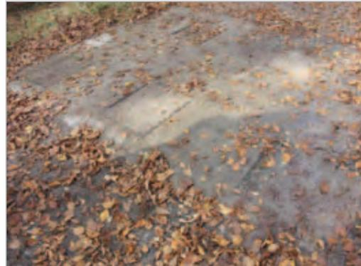
*Fundament für eine Stecksperre zur Sperrung eines Waldweges. In die heute zubetonierten Rechtecke wurden Stahlträger eingesteckt.*
